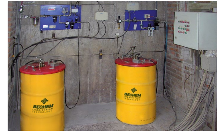
Bidones conectados a sistemas de pulverización con Berulit GA 2500
