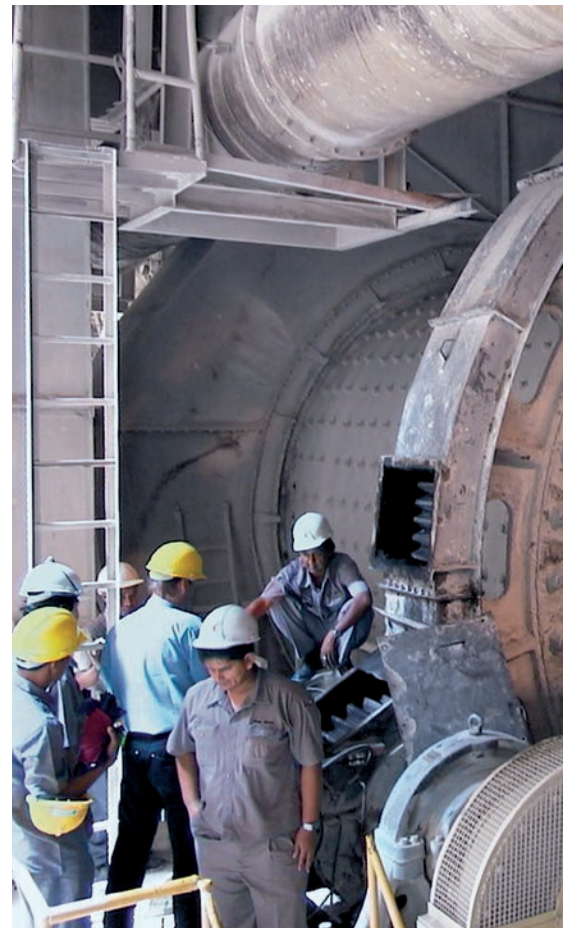
Inspección de un molino de bolas en una fábrica de cemento
