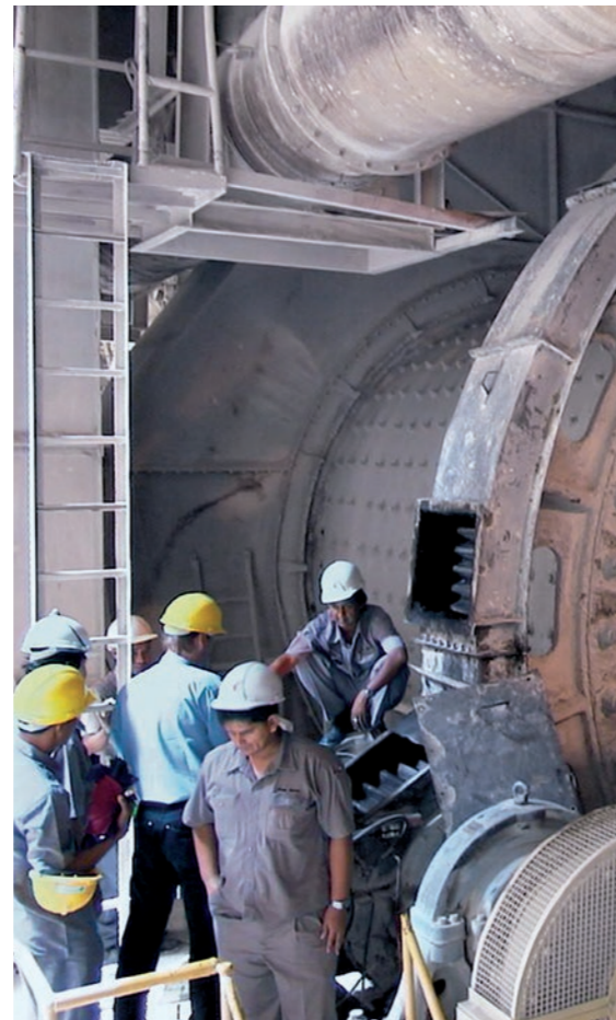
Inspektion einer Kugelmühle in einem Zementwerk
