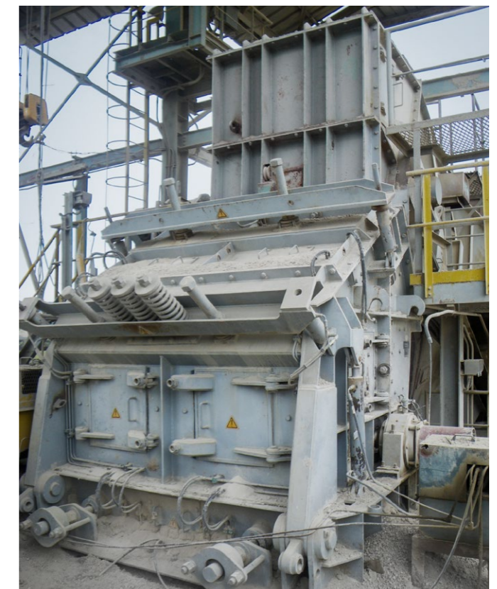
Machacadora de piedra caliza en una planta de cemento
