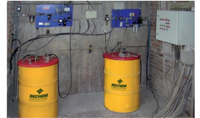
与 Berulit GA 2500 包装桶相连接的喷洒系统
